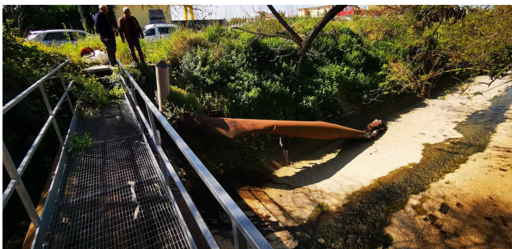
fig. 3_ passerella, tubazioni in acciaio di DN 500 mm, pozzetto di confluenza al collettore e tubazione DN 500 dismessa attualmente adagiata nel canale
