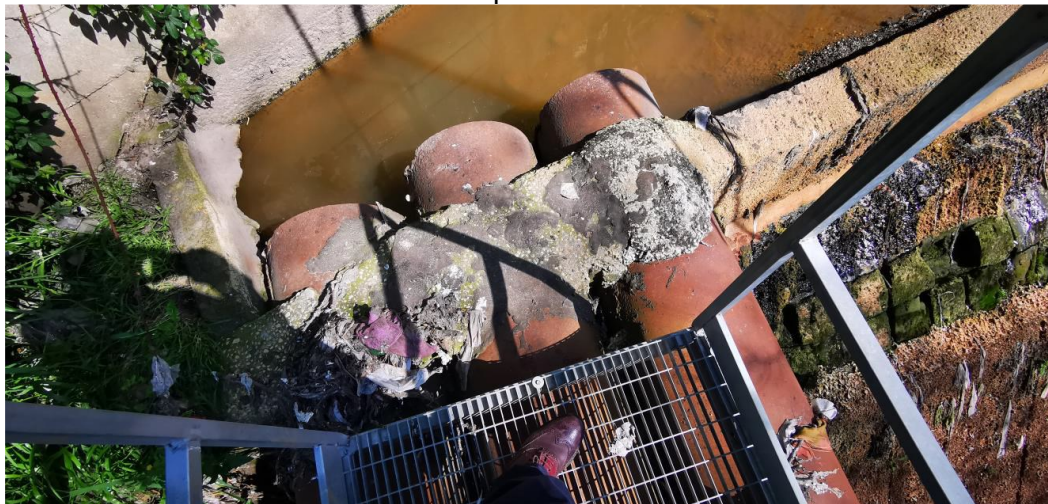
fig. 4 innesto scolmatore con tubazioni in acciaio di DN 500 mm
